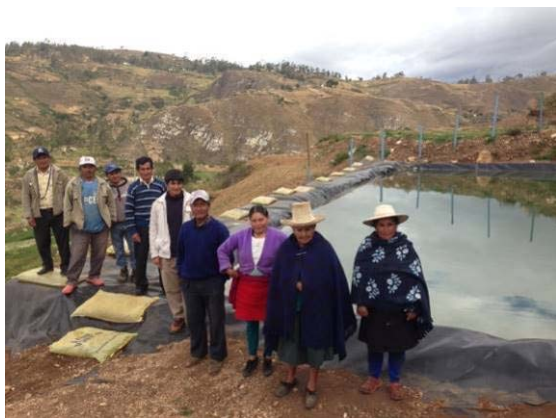
Caminata transversal en el reservorio construido en el caserío de Muya. Foto: Elena Borasino.
